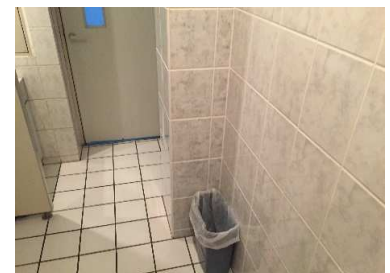
設置・内装復旧完了
