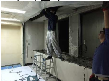
設置場所の解体
