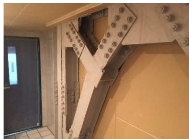
FFスタッド設置
