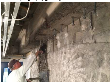
設置場所の解体
