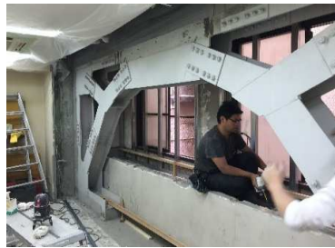
マンサード設置
