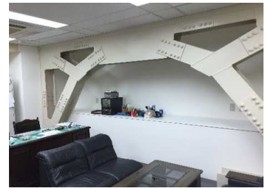
設置・内装復旧完了
